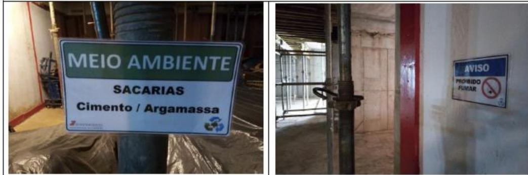
Fotos 1 e 2: Medidas preventivas à poluição da qualidade do ar interna estão sendo tomadas em obra como na proteção da sacarias, evitando a dispersão de particulados, bem como a sinalização informando a proibição do fumo nas áreas internas.
