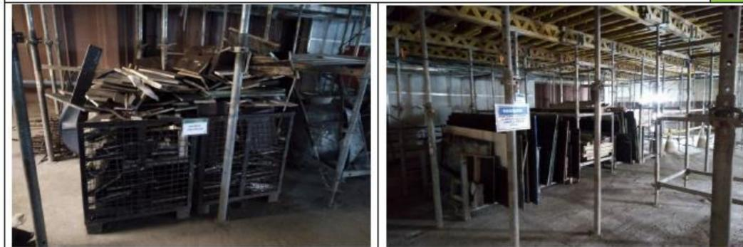
Fotos 3 e 4: Canteiro de obras encontra-se devidamente organizado, com áreas destinadas ao acondicionamento de madeira para reutilização.
