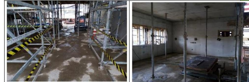
Fotos 9 e 10: As áreas internas da obra encontram-se devidamente limpas. Foi identificada a umectação das áreas prévia à varrição e limpeza dos ambientes.
